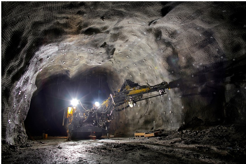
Bildtext: Borrigg under marken i Malmberget. Foto: Fredric Alm/LKAB
