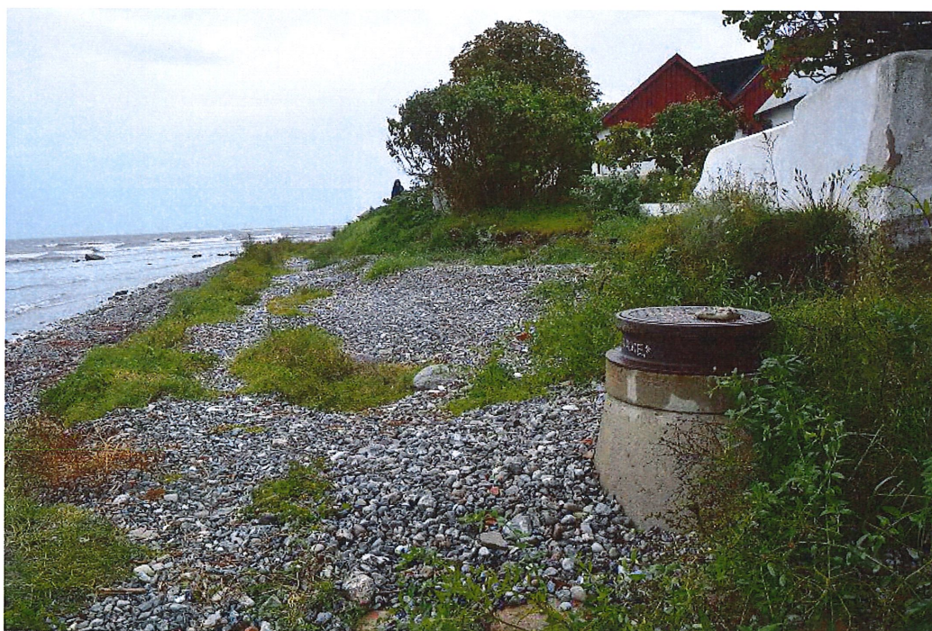
Bild 2. Dagvattenledning vid erosionsdrabbat kustområde i Trelleborg. Foto: SGI
