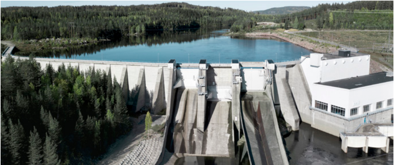
Som en del av Vattenfalls dammsäkerhetsprogram förbättrades säkerheten i Bodens vattenkraftverk (byggt 1967-72) under 2006 och 2007. Dammen förstärktes för att kunna hantera extrema vattenflöden som förväntas inträffa en gång på 10 000 år.
