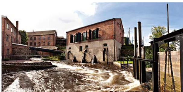
Foto: Tollereds Öfvre Kraftstation
