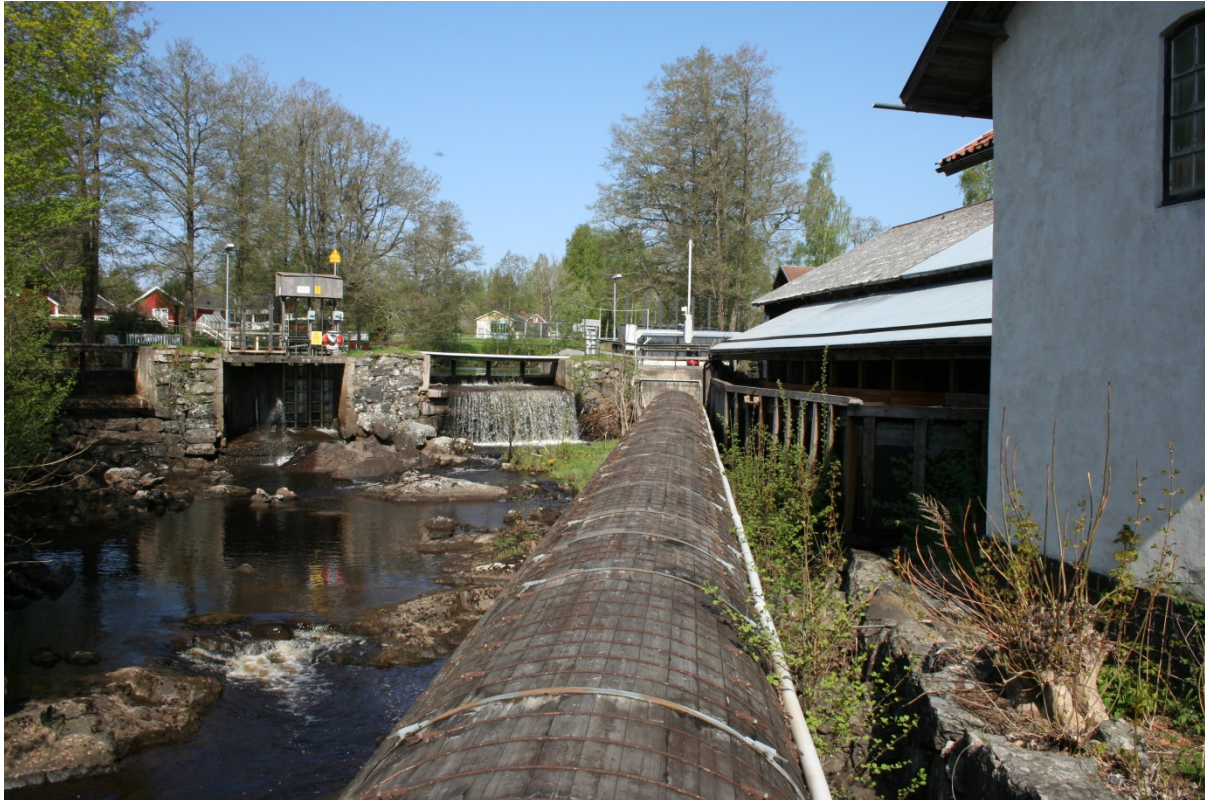
Karmansbo. Damm och trätub som leder vattnet till kraftstationen. Foto: Torsten Nilsson
