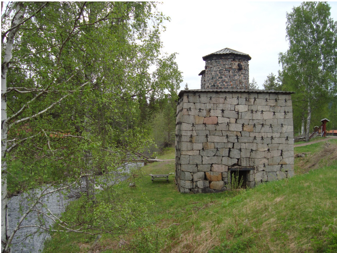
Masugnen i Siljansfors. Foto: Torsten Nilsson
