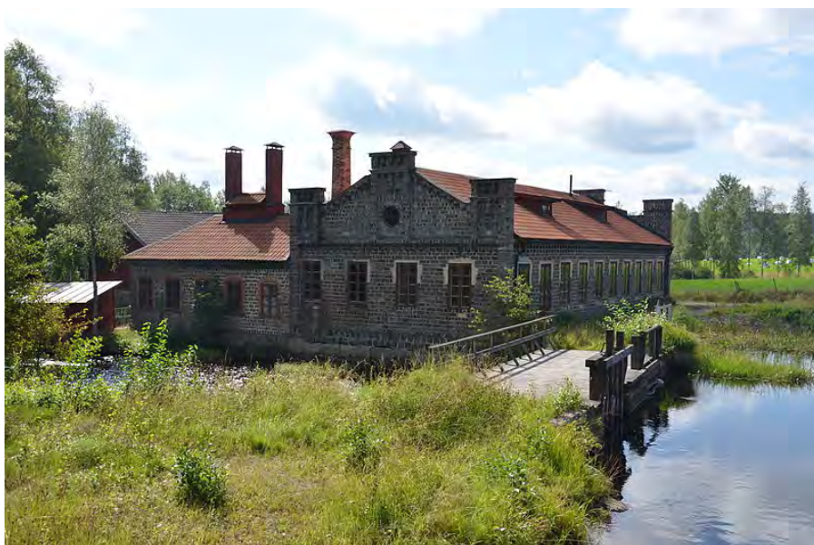
Dammen vid verkstaden. Foto: Wiki Commons, Bengt Oberger
