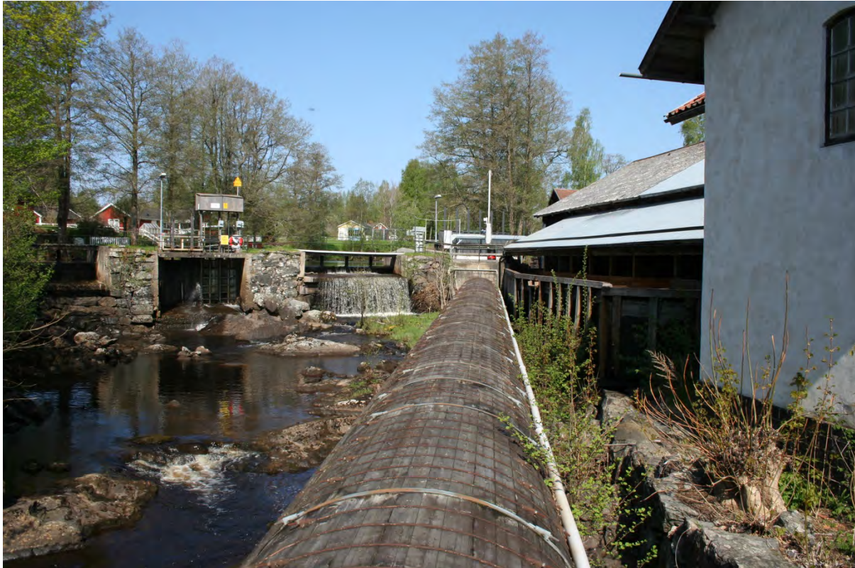
Karmansbo. Damm och trätub som leder vattnet till kraftstationen. Foto: Torsten Nilsson
