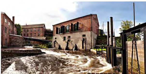
Foto: Tollereds Öfvre Kraftstation
