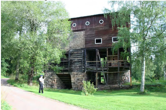
Masugnen Norns bruk. Foto: Torsten Nilsson
